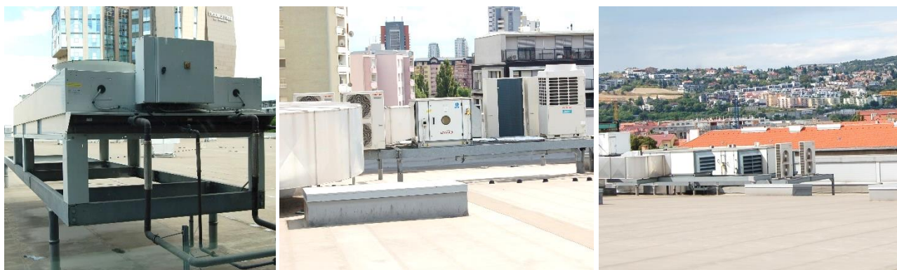
Obr. 17: Chladiace zariadenia na streche objektu
